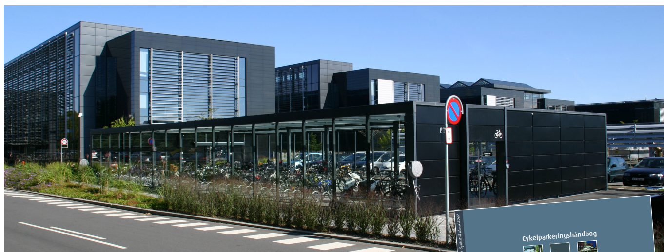
Lækker indendørs cykelparkering lige ved hovedindgangen til stor dansk arbejdsplads.
