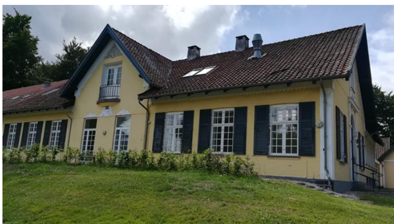
Hovedbygningen med bl.a. Korspostvinduer med fire-rudede overrammer og otte-rudede underrammer.
