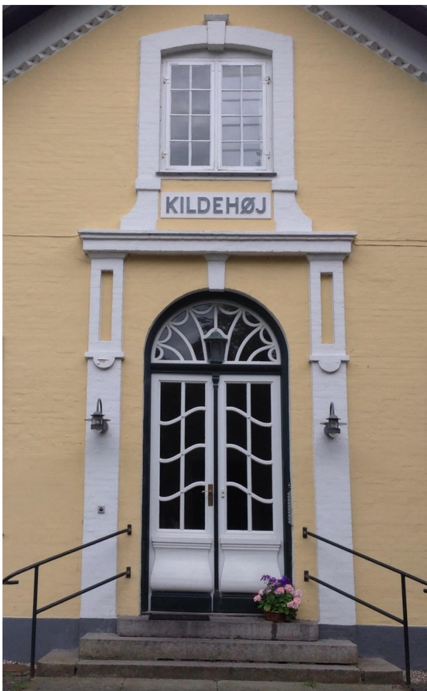
Indgangspartiet ved hovedbygningens nordvendte gavl.
